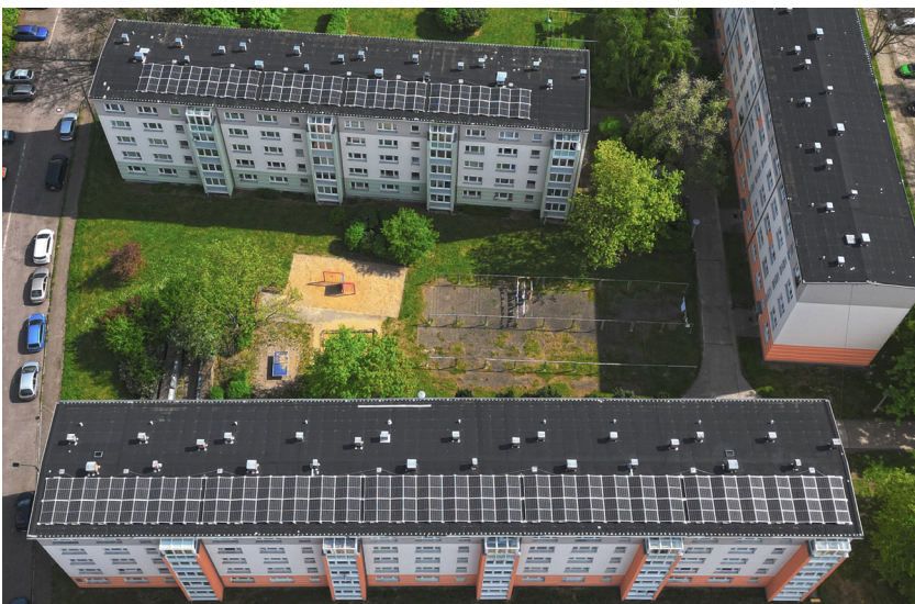
Photovoltaik-Anlagen auf den SPARCS-Gebäuden im Dunckerviertel (Quelle: WSL Wohnen & Service Leipzig GmbH, Martin Klingemeier)
